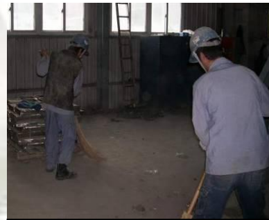
要求承攬商在自己承攬工程的作業區，於每日作業結束時應自行清潔環境，可避免人員發生跌倒的危險並維持工安紀律。
