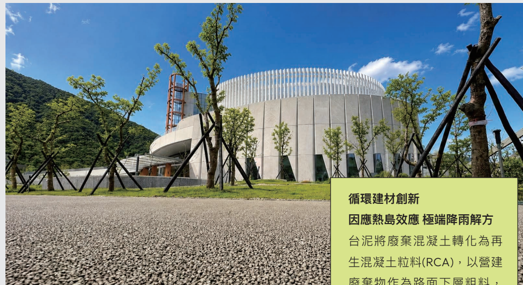
和平廠RRRC透水混凝土鋪面
