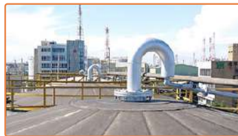
呼吸閥設置連接管
