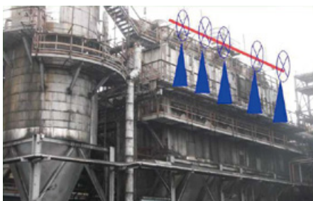
製粒區及收集區增設灑水系統設置
